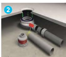
Introduce la tubería, la junta y aprieta la tuerca. O encolla si es de PVC.
