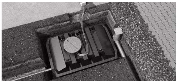
Instalar CU (5 m máximo del tanque)
