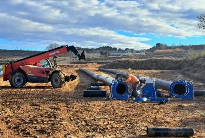
**Infraestructura:** Modernización del sistema de riego, 25KM de tubería Flexipol PE100.
