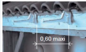
En algunas instalaciones a pared será necesario el uso de prolongadores para situar el perfil canalón en la posición idónea de recogida.
