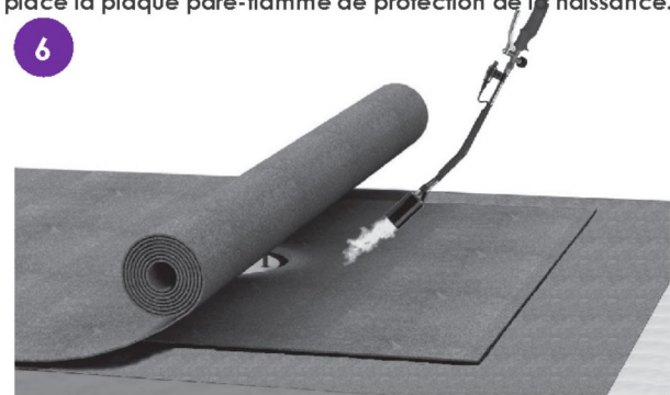
6 Souder à la flamme ouverte la seconde couche d'étanchéité
