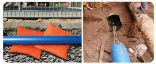
Especialmente recomendado para las aplicaciones con tecnología sin zanja por su alta resistencia a la abrasión: Perforación dirigida, Bursting, Relining...
