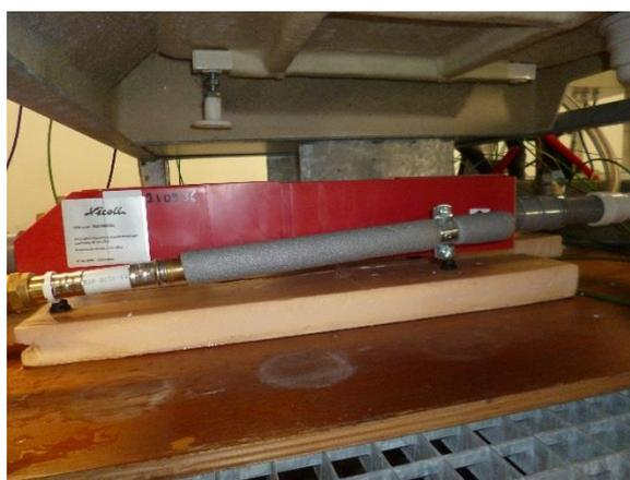
Raccordement de l'entrée des eaux de douche et de la sortie de l'eau préchauffée
